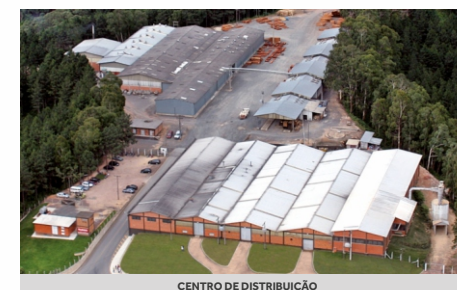
CENTRO DE DISTRIBUIÇÃO
