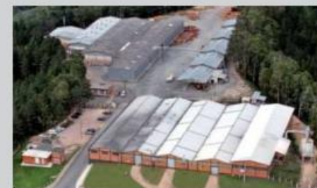
CENTRO DE DISTRIBUIÇÃO
