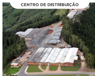
CENTRO DE DISTRIBUIÇÃO
